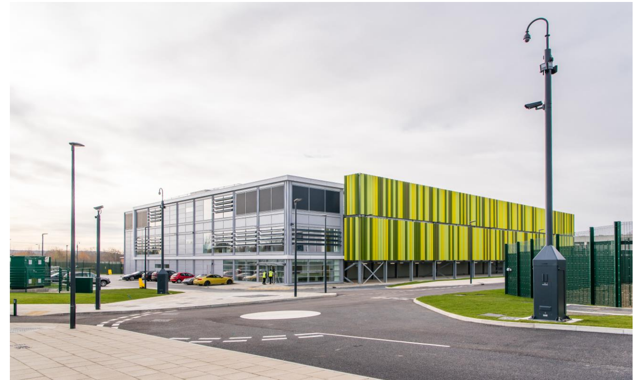
Kao Data Harlow Campus
