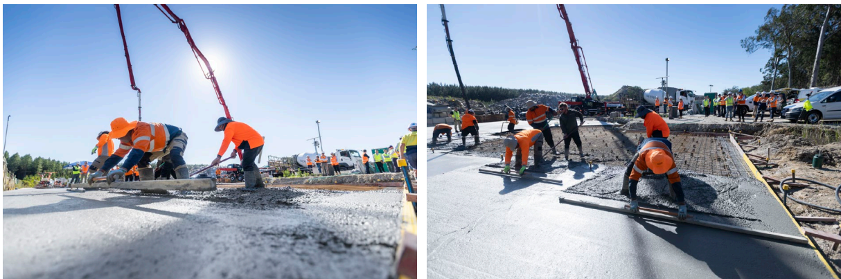
Figure 1: AusPozz™ Commercial-Scale Concrete Demonstration Pour
