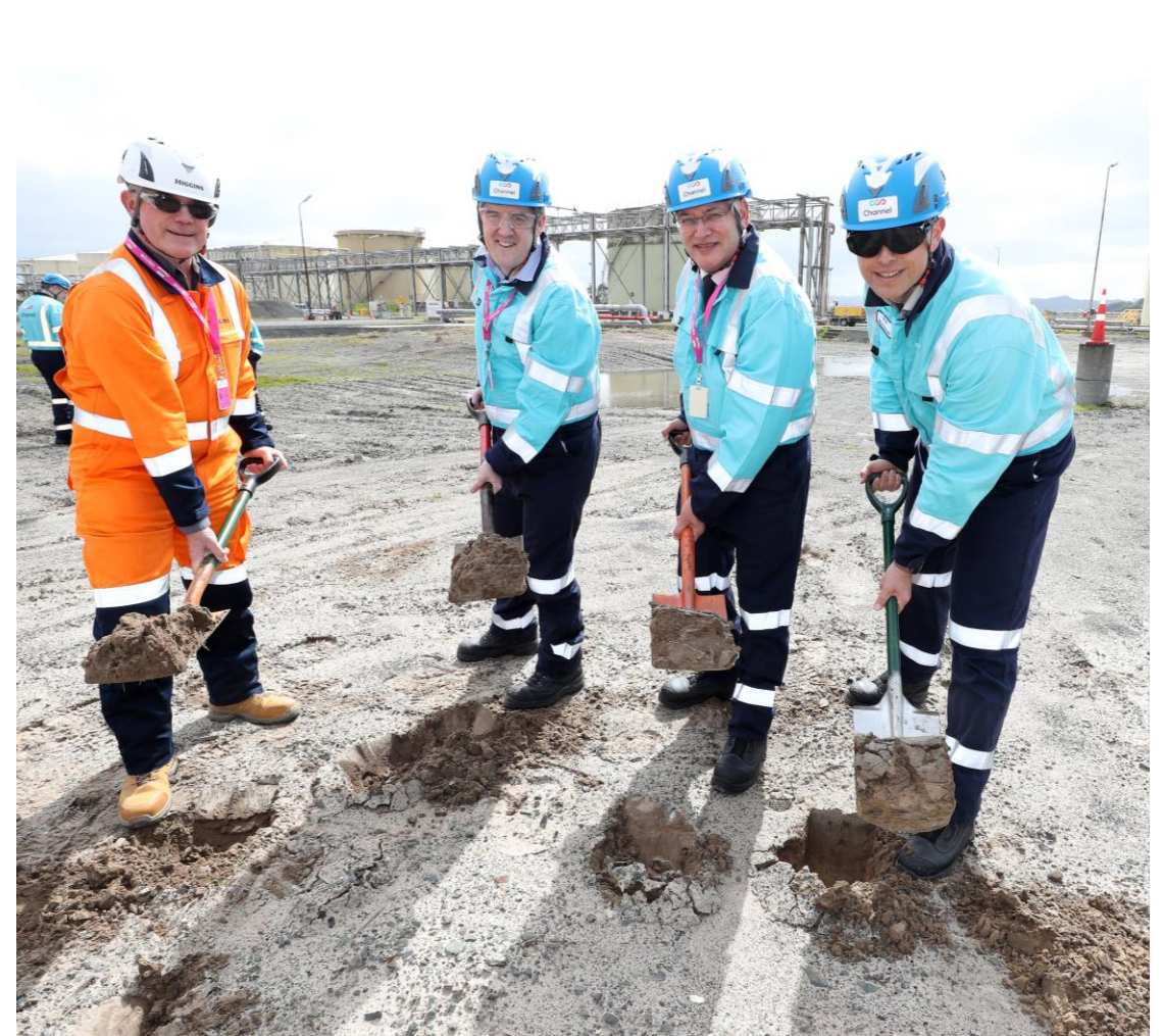
Bitumen Import Terminal
